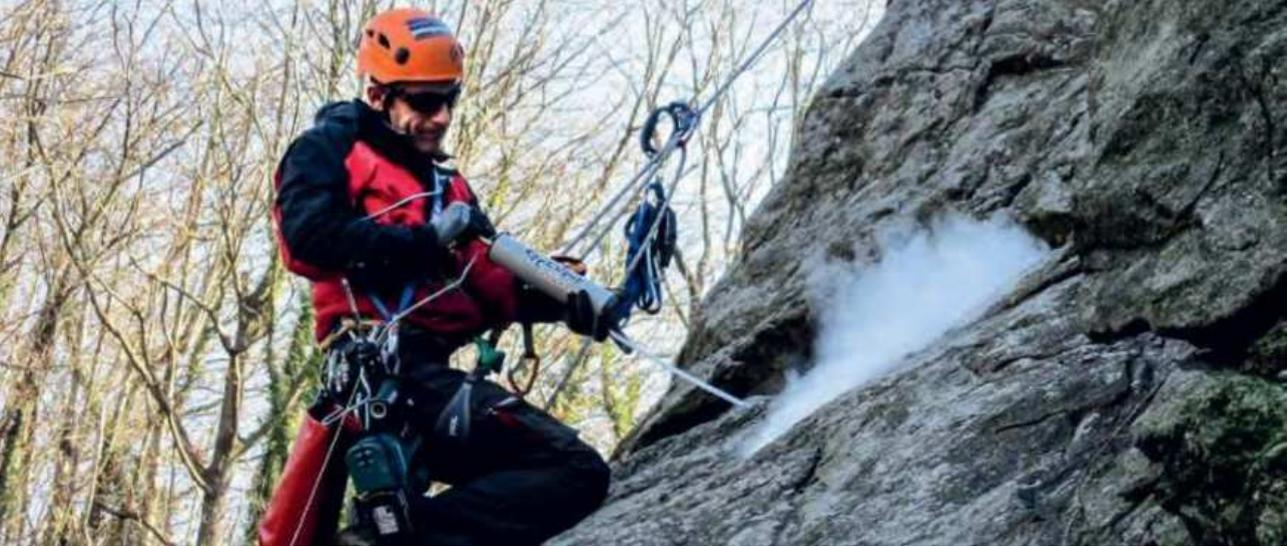
*Pulizia del foro mediante soffiaggio (per la messa in posa dello spit)*
