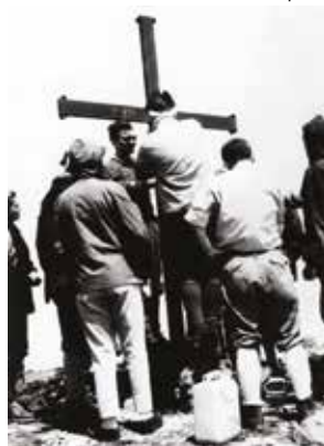
I lavori di posa
