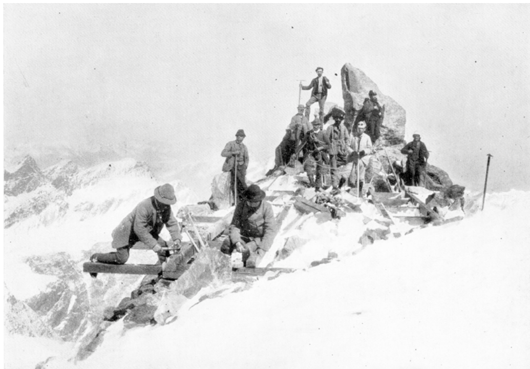
Lavori di fondazione della capanna-osservatorio Regina Margherita sulla Punta Gniffetti
