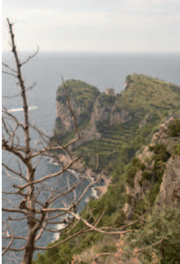
Torre di avvistamento nella Baia di Ieranto
