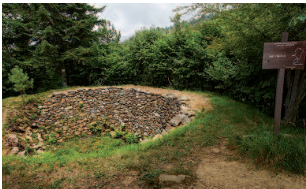
Neviera ristrutturata dal CAI Bolzaneto
